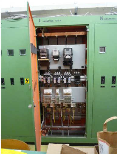
Leistungsschalterschiedlicher Generationen
