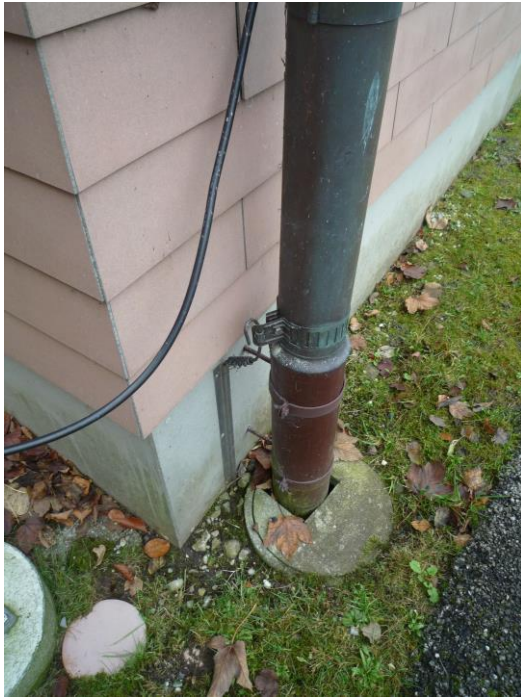
Beispiel Dachwasserfallstrang als Ableitung
