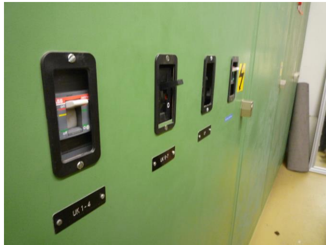
Neue Leistungsschalter passen nicht in Türausschnitte
