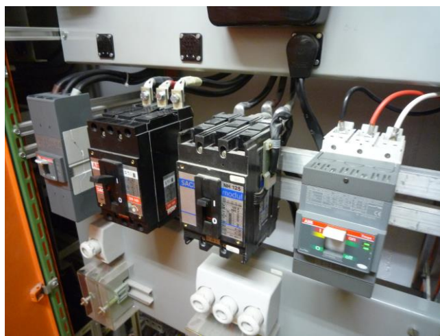
Neue Leistungsschalter passen nicht in Türausschnitte
